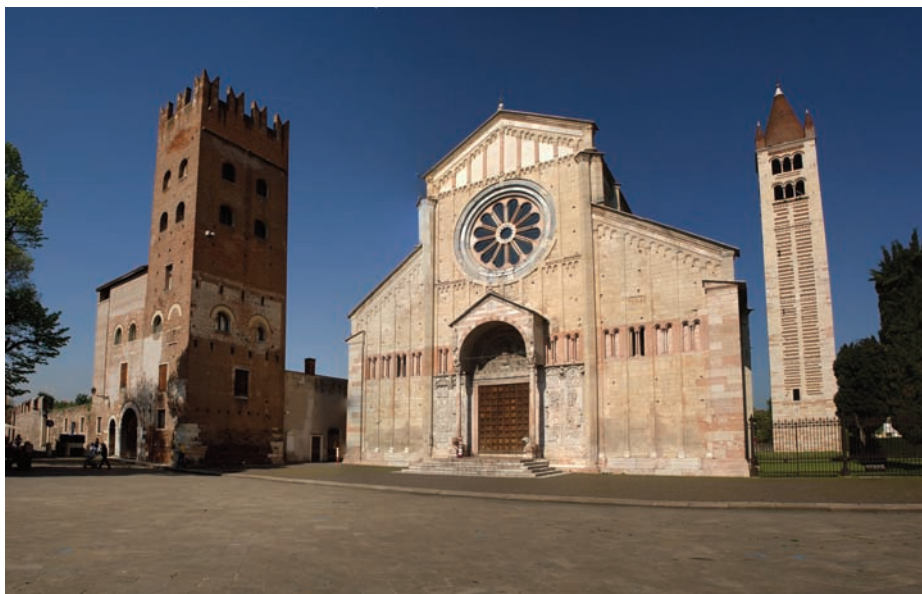
Fig. 1. La Torre di Pipino et le complexe résidentiel de l'angle nord-ouest de l'abbatiale San Zeno à Vérone.
