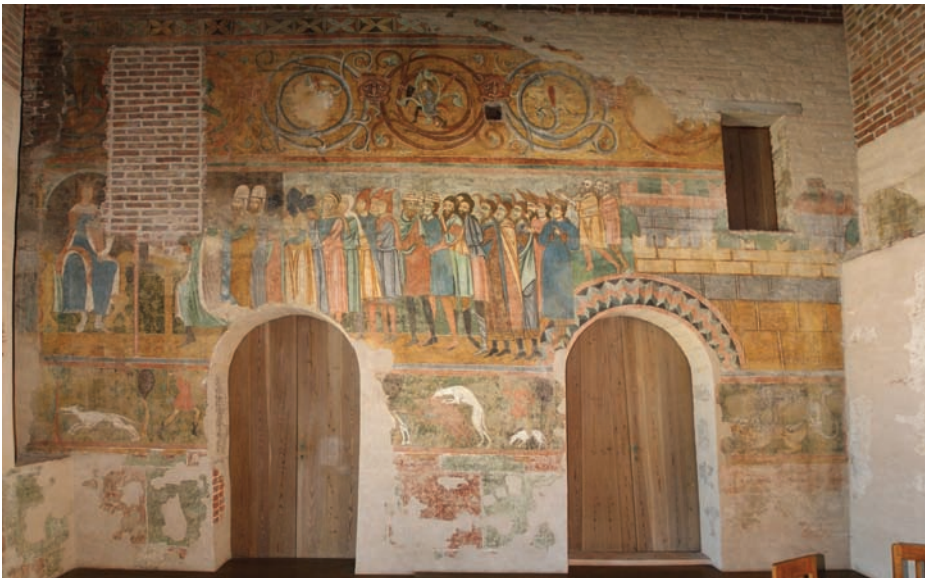
Fig. 2. Vue d'ensemble des peintures murales de la paroi Sud du premier étage.
